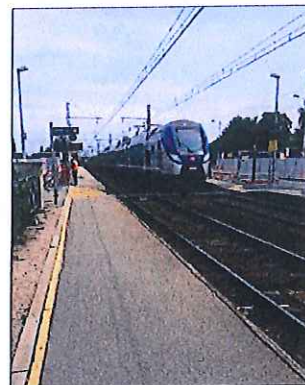
■ La deuxième phase des travaux va débuter en septembre.
