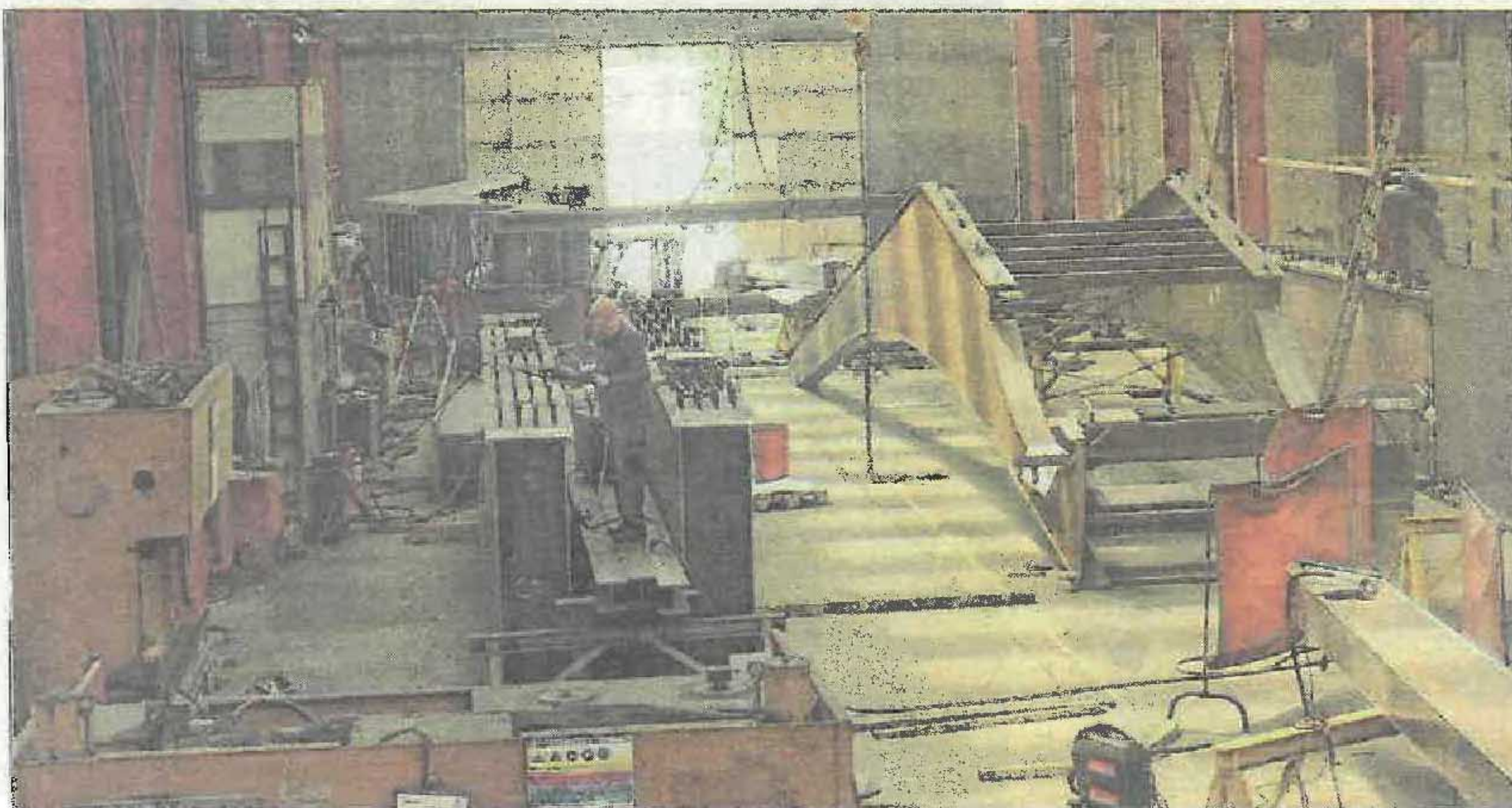
■ C'est dans cet atelier que sera fabriquée la passerelle. Photo Claude LANGELLA
