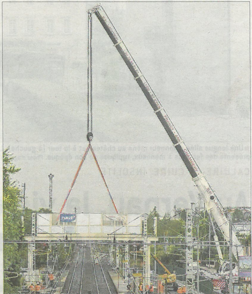
■ Le tablier de la passerelle est en place. Photo Claude LANGELLA
