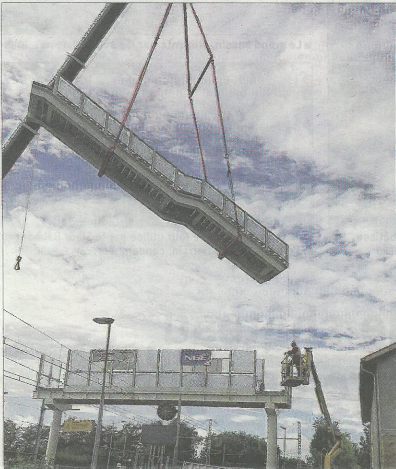
■ Les escaliers d'accès ont été installés à l'aide d'une grue. Photo Claude LANGELLA
